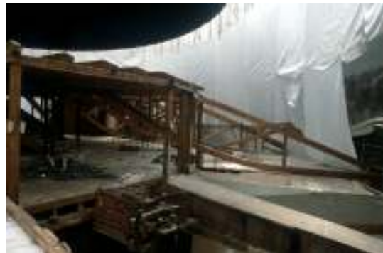
Abb. 4: Blick in den Bildinnenraum vor dem Rückbau. Zum Schutz gegen Staub und mechanische Beschädigungen ist vor das gesamte Gemälde ein Schutzvorhang montiert worden.
