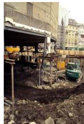
Abb. 5: Damit die Untergeschosse ausgehoben werden konnten, ist das ganze Panoramagebäude auf Eisenpfähle gestellt worden.
